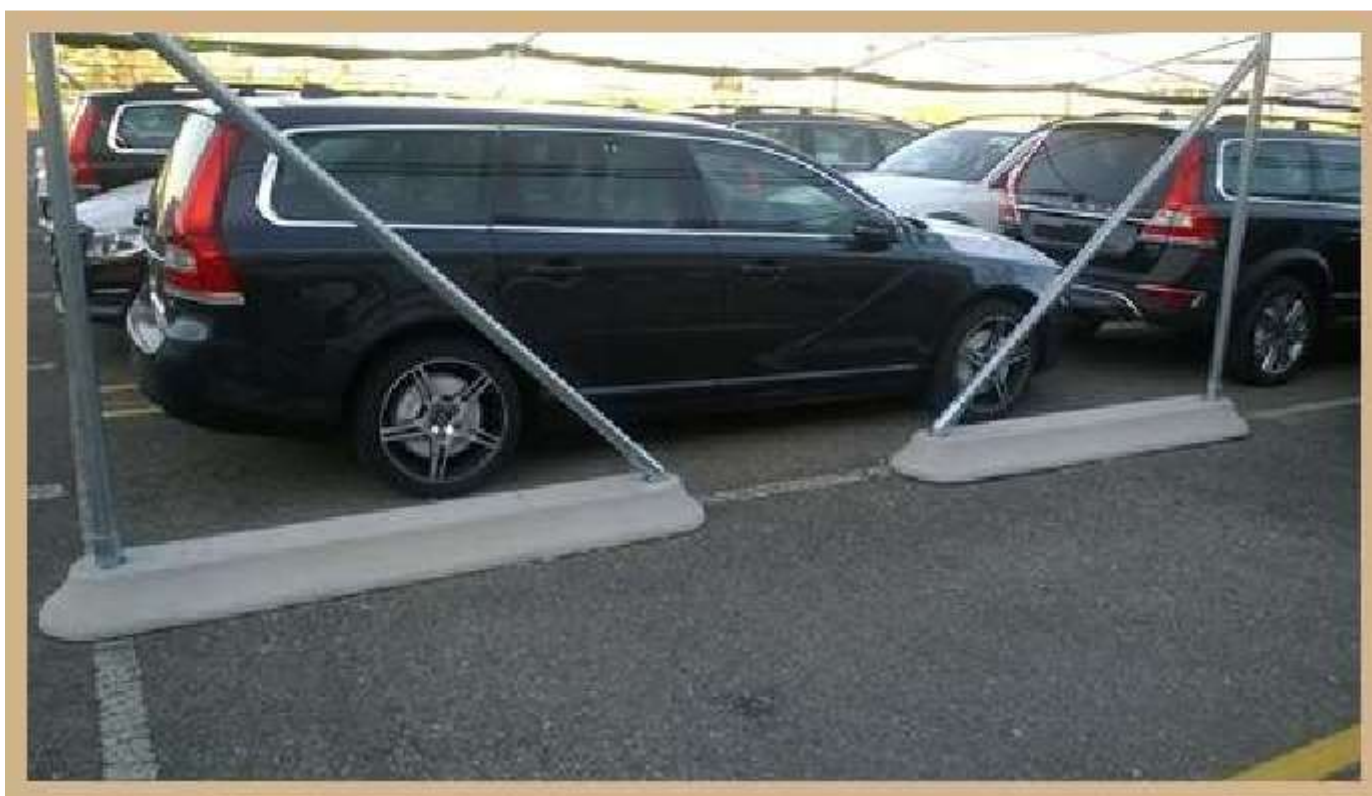
PARTICOLARE CONTROVENTATURE AD Y
