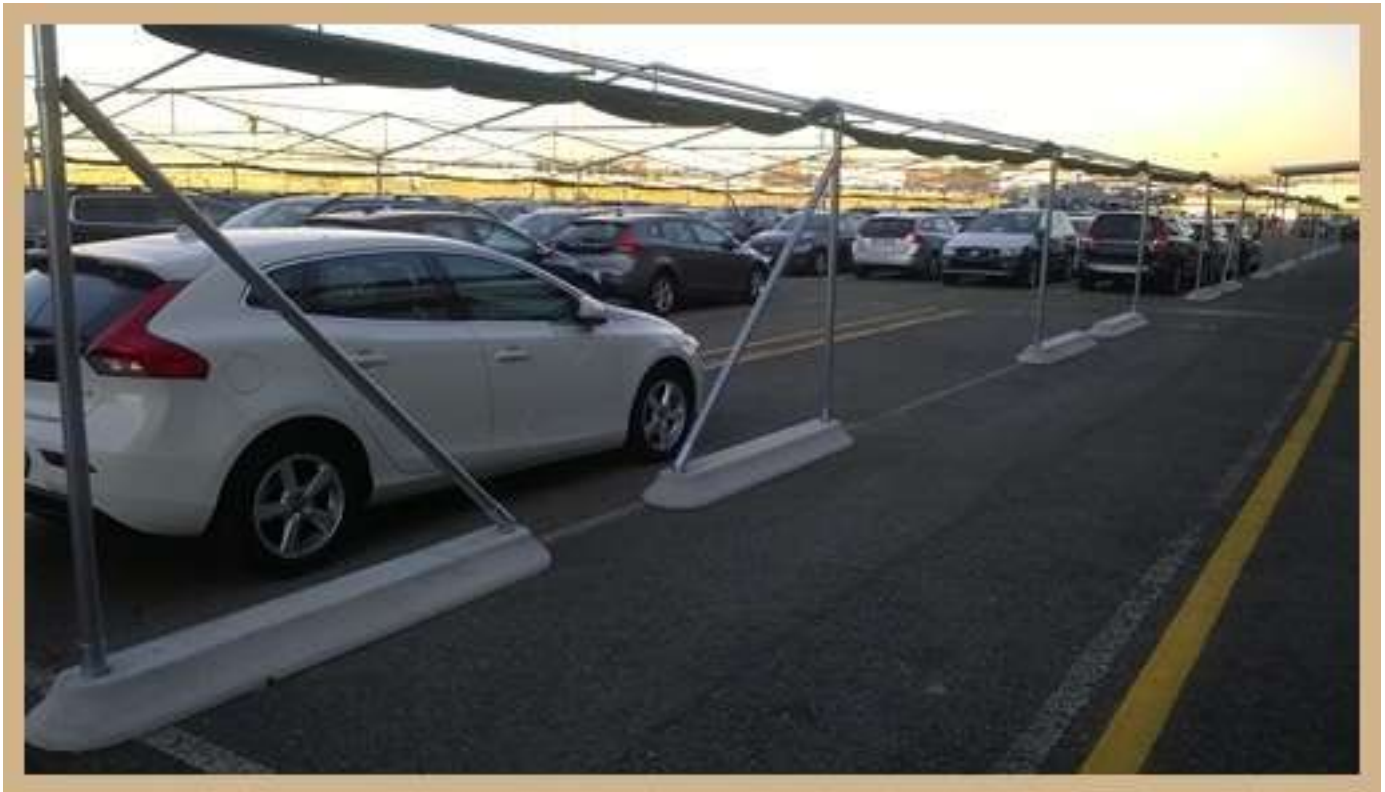
Logistica "Deposito Volvo Italia" - Cassano Magnago (VA)
